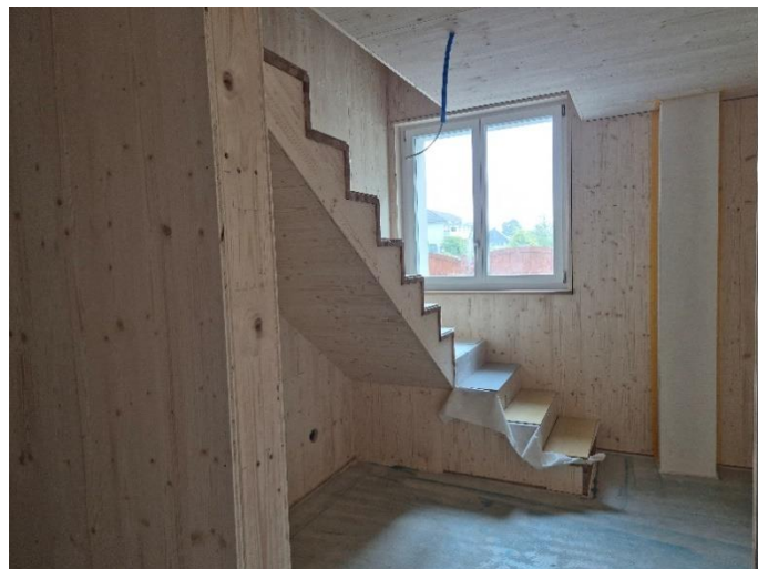
Tagesschule (Aufgang Mezzanine/Ruheraum)
